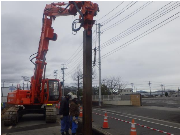
親杭設置状況
