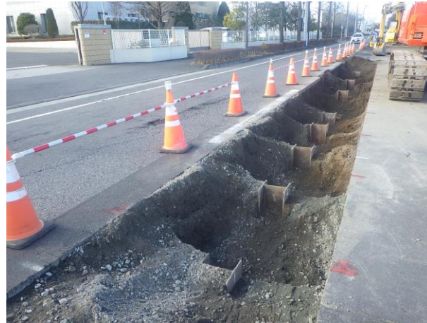
親杭設置完了
