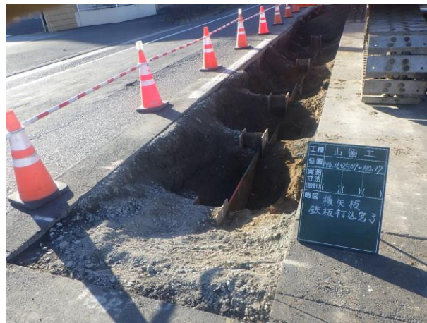
横矢板設置完了
