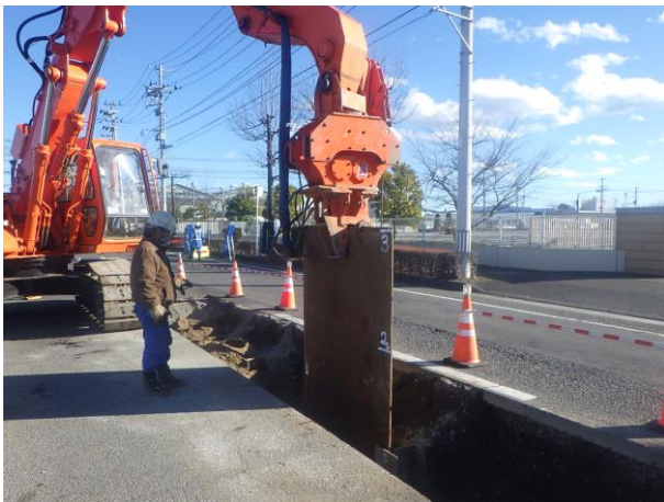
横矢板設置状況
