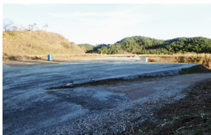
従前の状態（河内埋立処分場）
