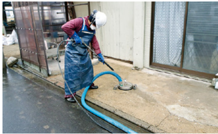
一般住宅の吸引式高圧洗浄
