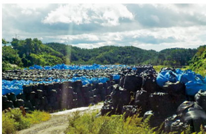
除去土壌保管・積込・搬出中
