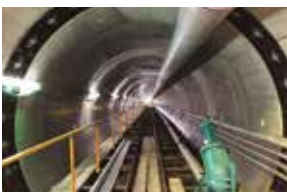
図景貯留管内部
