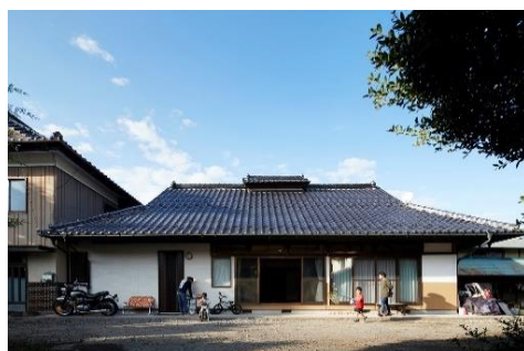
▲ 古民家の性能向上リノベーション
