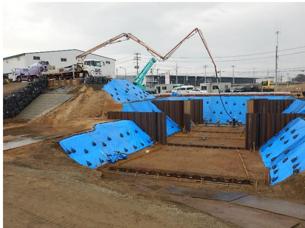
均しコンクリート施工状況
