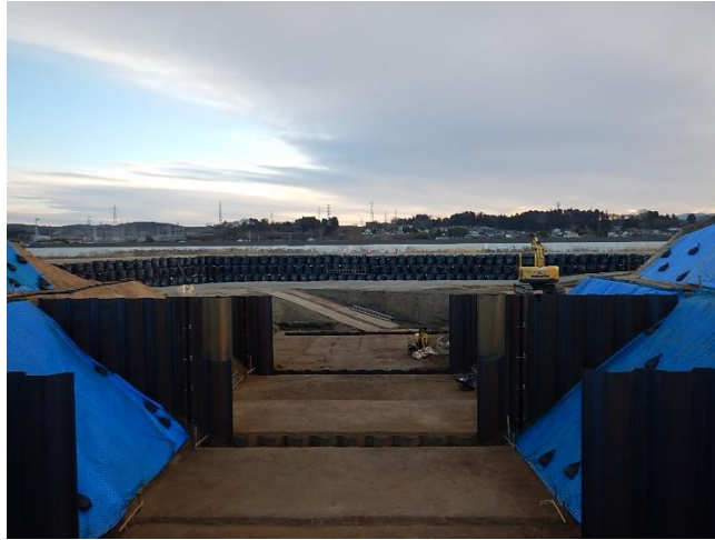
しゃ水矢板設置完了
