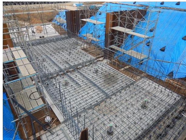
鉄筋組立完了（底版）
