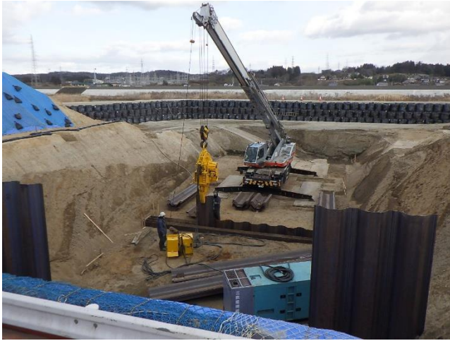
しゃ水矢板設置状況
