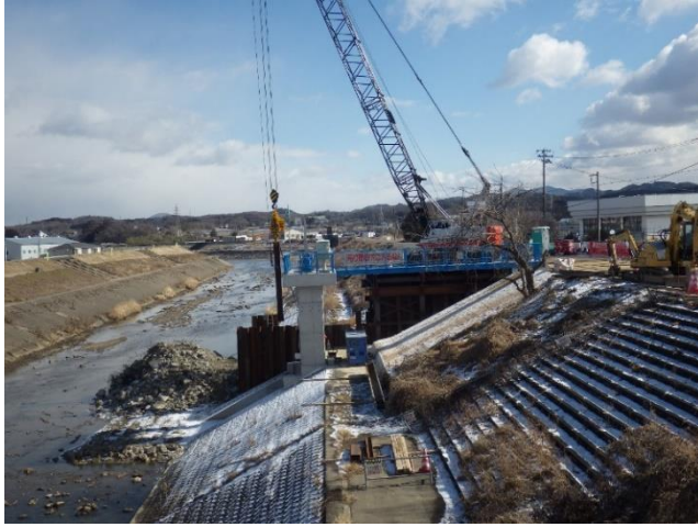
仮棧橋撤去状況
