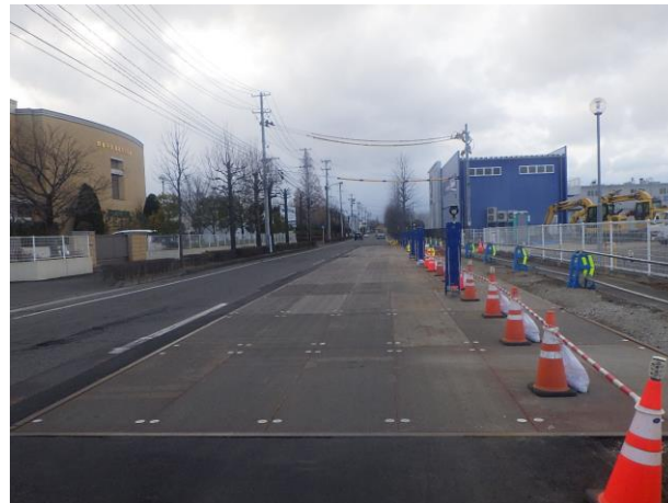
覆工板設置完了
