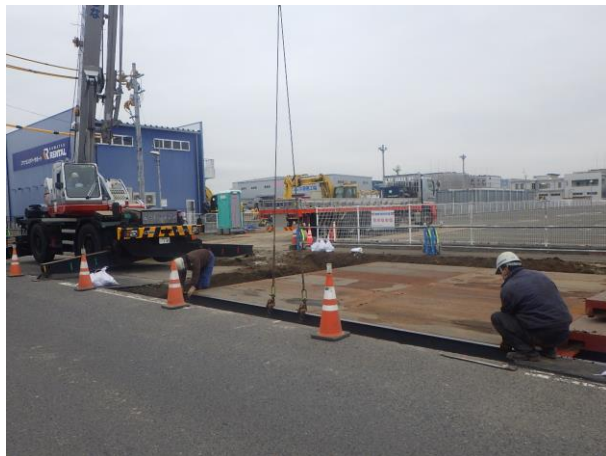
覆工板設置状況
