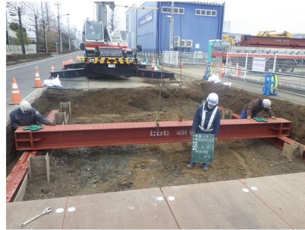
桁受設置状況
