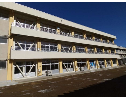
【赤木小学校校舎 長寿命化改修】
