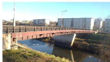
▲予防保全橋梁 ・赤坂橋（橋長 57.3m、幅員 7.0m）
