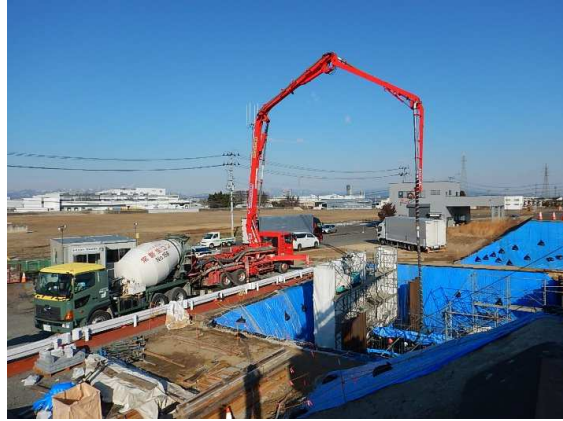
樋門コンクリート打設状況（底版）
