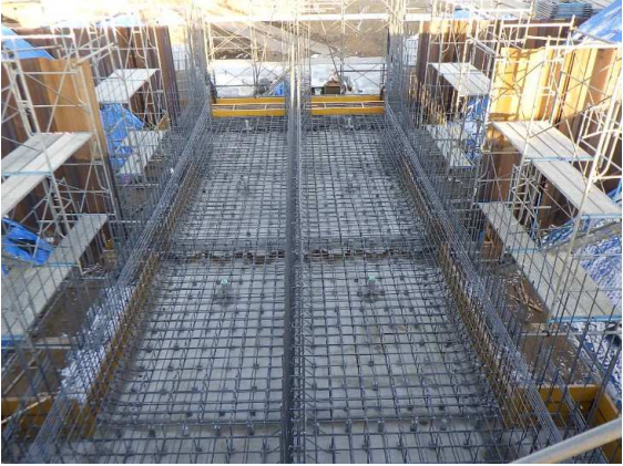
樋門配筋完了（底版）
