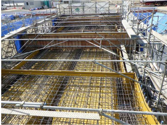
樋門コンクリート型枠完了（頂版）
