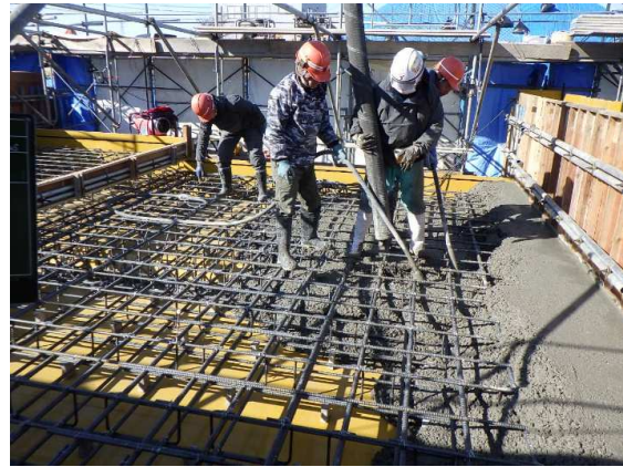
樋門コンクリート打設状況（頂版）
