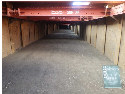
碎石基礎完了
