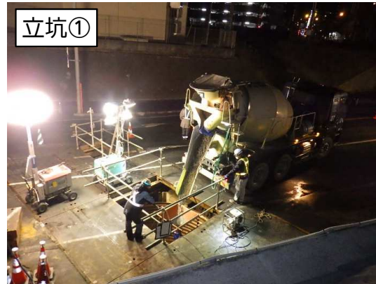
No.1-1マンホールコンクリート打設状況
