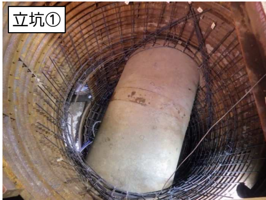
No.1-1マンホール配筋施工状況
