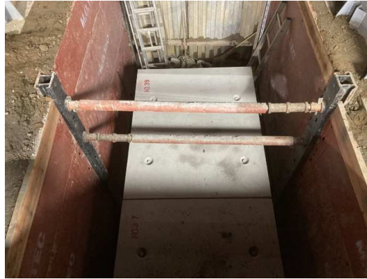
ボックスカルバート設置完了
