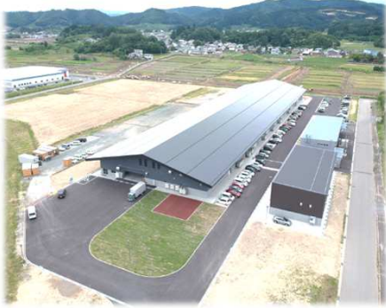
秋田本社（2017年7月竣工）
