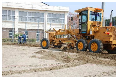
写真：小学校校庭の表土除去の様子
