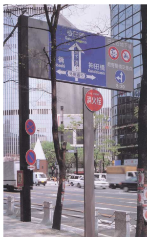
標識類は整理、統合され、附属物も統一したデザインで整備した道路
