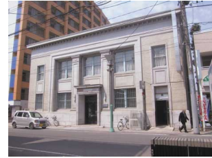
東邦銀行中町支店 (旧郡山商業銀行) 昭和13年竣工(1936)
