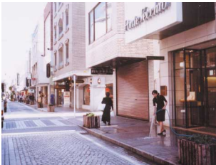
沿道建築物等のルールづくりと道路整備が一体に行われた町並み
