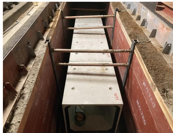
ボックスカルバート設置完了
