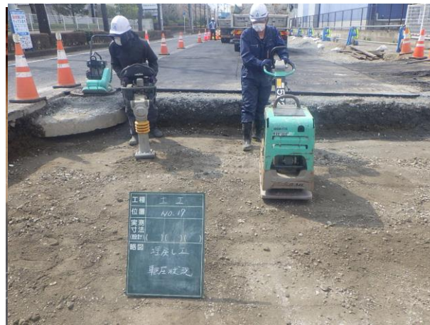
埋戻し転圧状況
