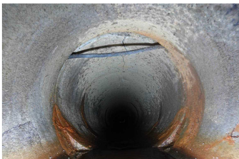
点検ドローンによる管路調査映像
