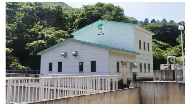
高濁度処理施設(深沢川取水場)
