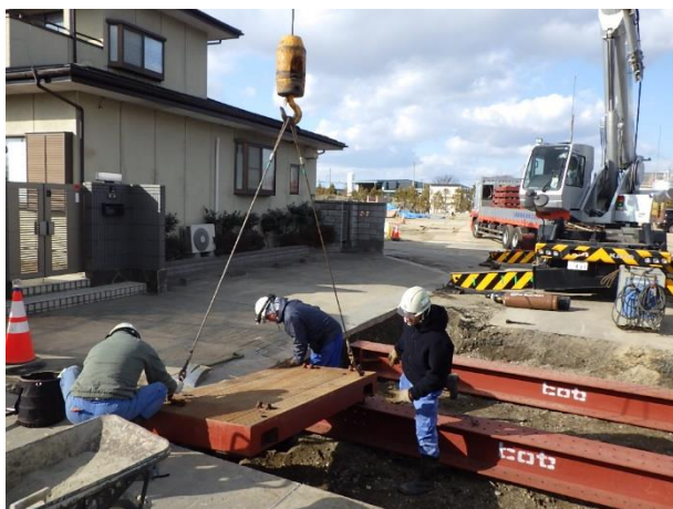
覆工板設置状況
