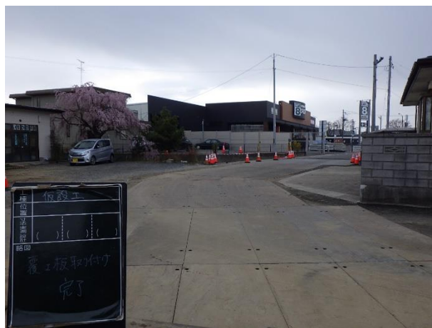
覆工板設置完了
