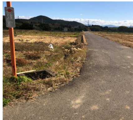
復旧後の様子
