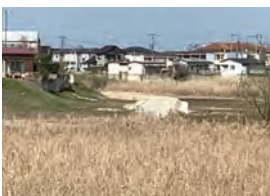
河道掘削の工事用通路
