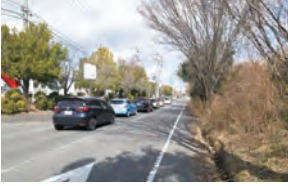
大型商業施設の周辺道路
