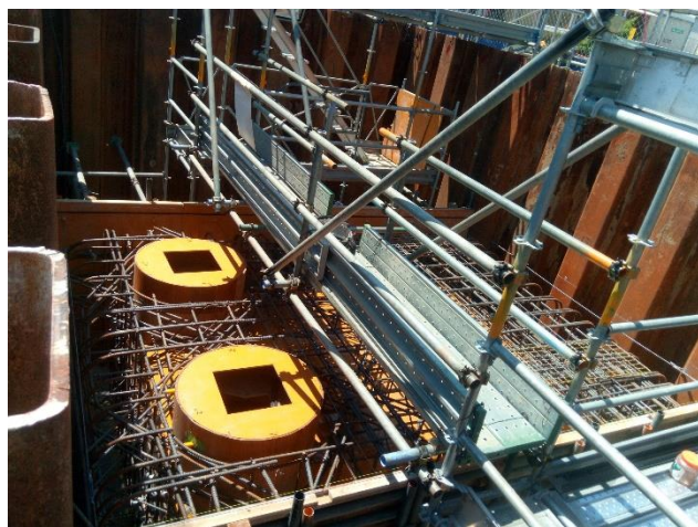
頂版配筋完了 (特殊人孔No.1)
