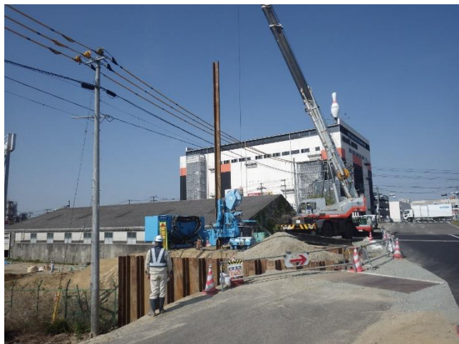
土留め設置状況（既設放流渠撤去）
