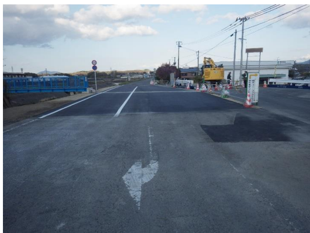
堤防道路本復旧一部完了
