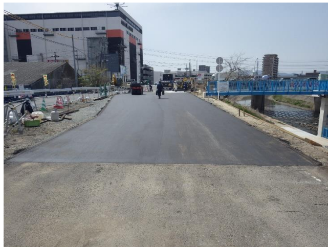
堤防道路本復旧状況
