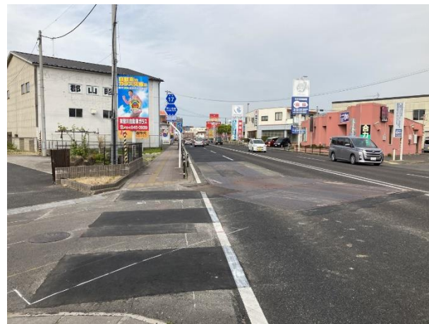
覆工板設置完了
