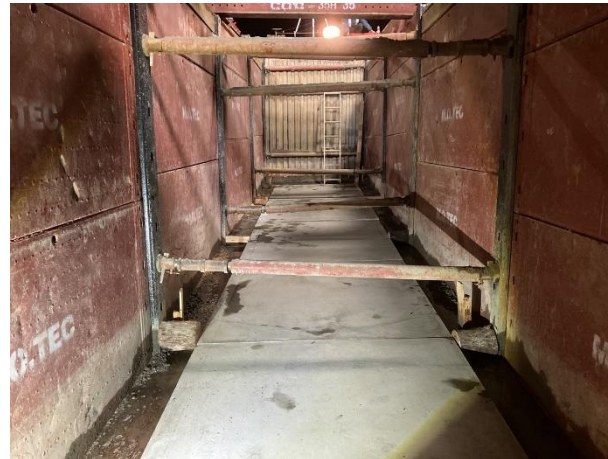
土留め矢板設置完了
