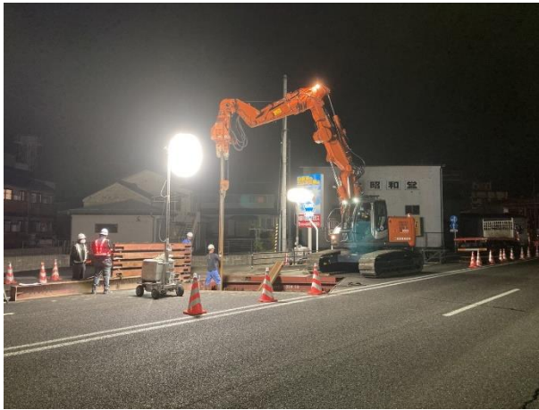
土留め矢板設置状況
