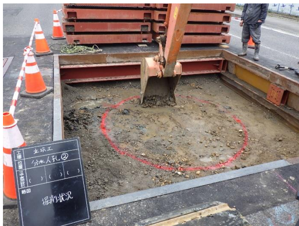
分水人孔②掘削状況
