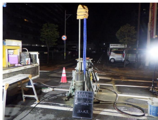
分水人孔③薬液注入状況
