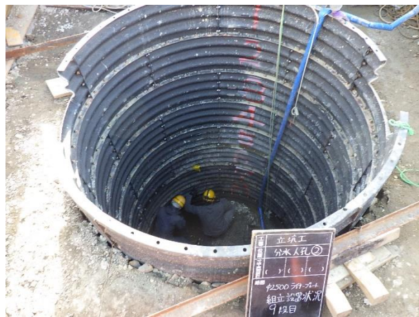
分水人孔②土留（ライナープレート）組立状況
