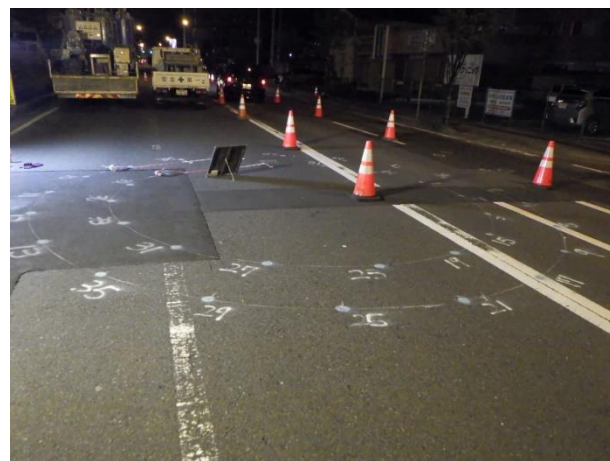
分水人孔③薬液注入箇所マーキング状況
