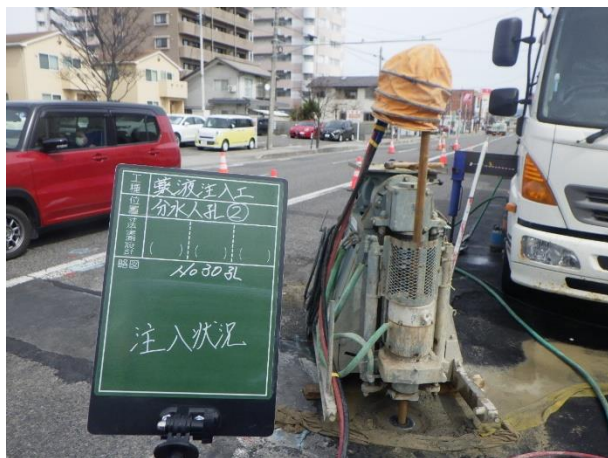
薬液注入状況
