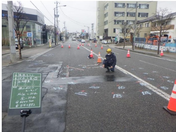
薬液注入箇所マーキング
