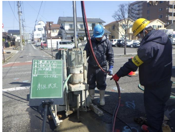
薬液注入箇所削孔状況
