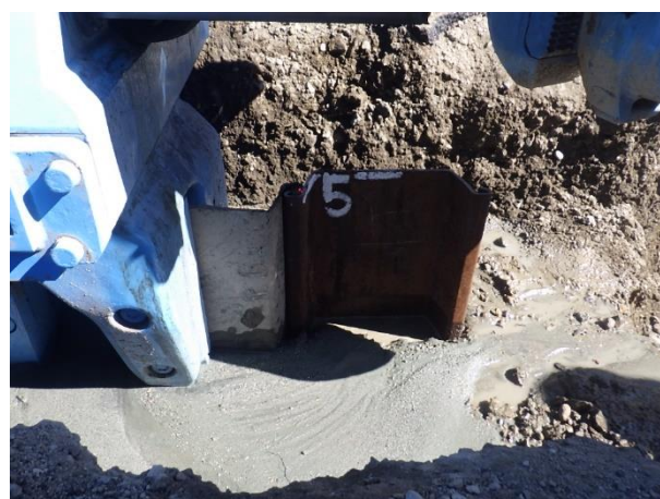
鋼矢板圧入状況
