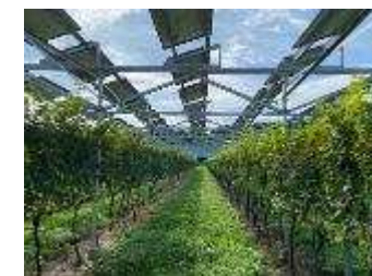
【営農型太陽光発電の設置例】 パネルの下でブドウを栽培
