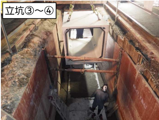
函渠布設状況
