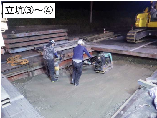
函渠埋め戻し状況
