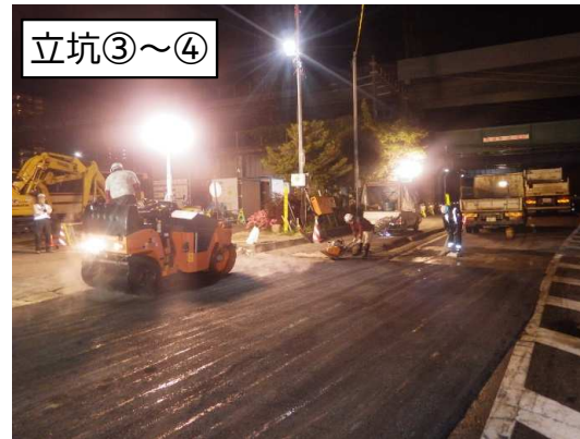
仮復旧施工状況
