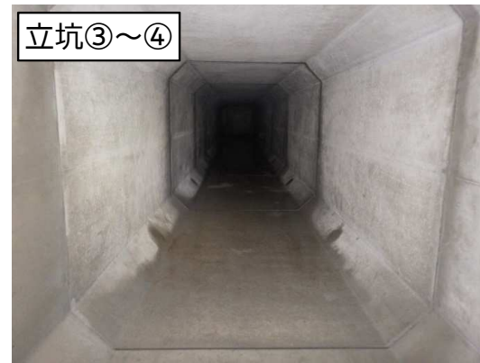
函渠布設完了
