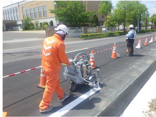
区画線復旧状況
