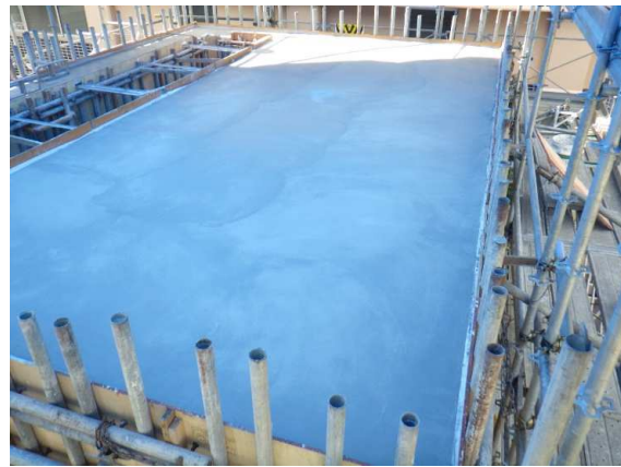
コンクリート打設完了（3ロッド）
