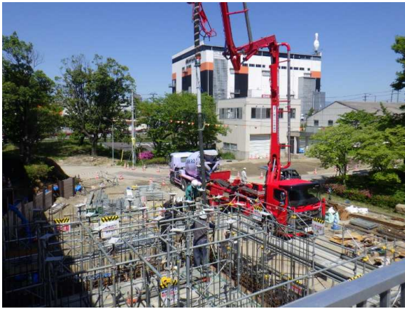
コンクリート打設状況（2ロッド）
