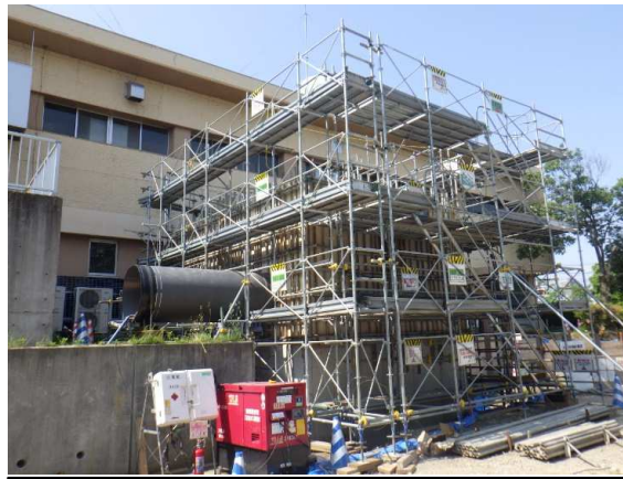
鉄筋・型枠組立完了（3ロッド）
