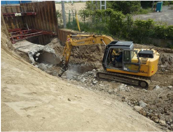
既設放流渠撤去状況
