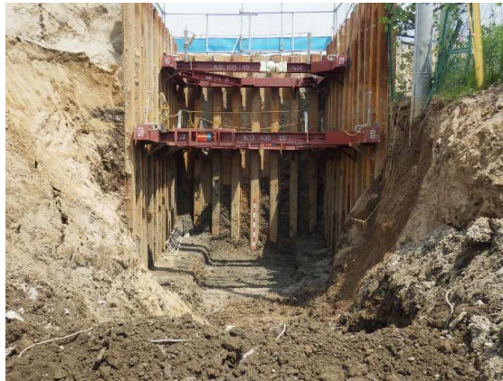
既設放流渠撤去完了
