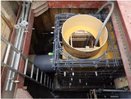
分水人孔②鉄筋組立状況
