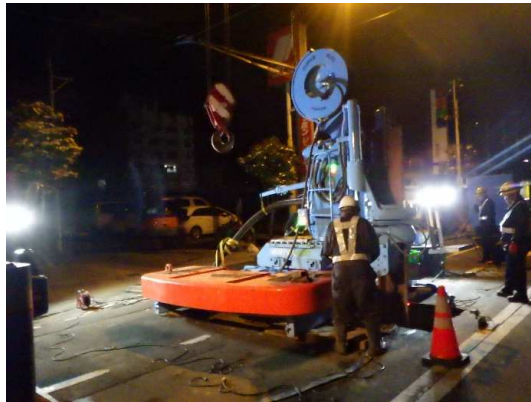
分水人孔③土留設置状況
