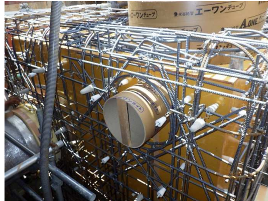
分水人孔②型枠組立工状況
