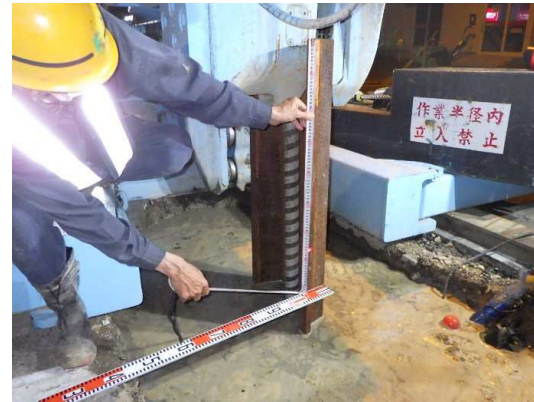
分水人孔③土留設置状況
