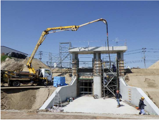
扉体設置状況
