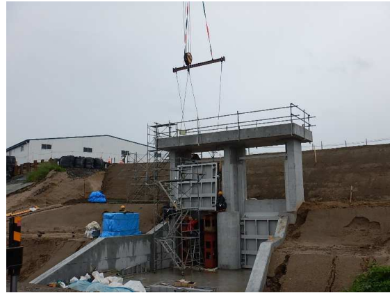
扉体設置状況
