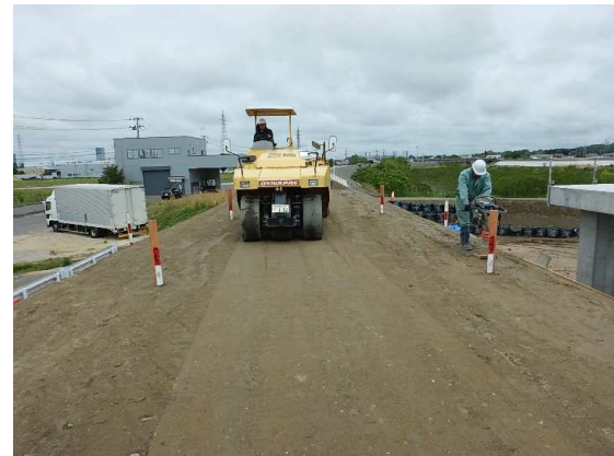
築堤施工状況
