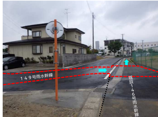
舗装復旧状況 (東側から西側を望む)
