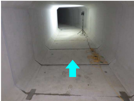
ボックスカルバート内部状況
