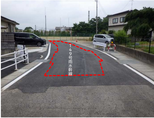
舗装復旧状況 (南側から北側を望む)
