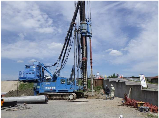
コンクリート杭施工状況
