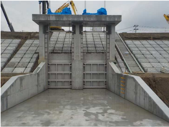
樋門設置完了
