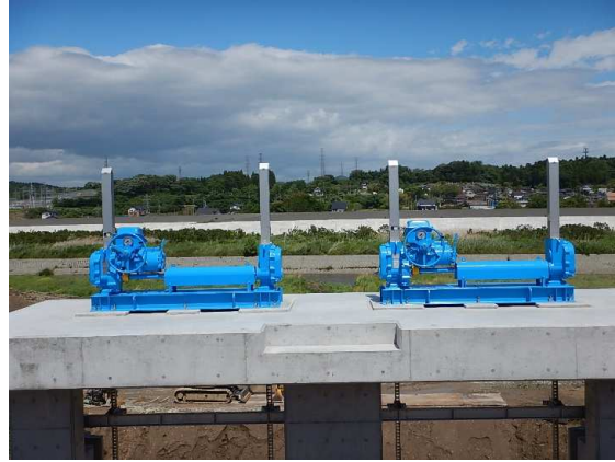
樋門設置完了
