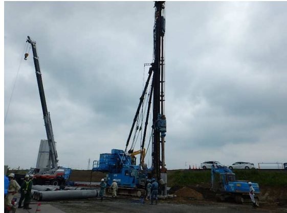
コンクリート杭施工状況
