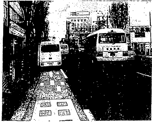
自転車専用レーンに商用車が停車し、自転車通行の妨げになっている
