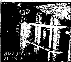
福島第一原発1号炉格納容器内部ベドスタル開口部むき出しの鉄筋(東電水中ロボットの調査)
