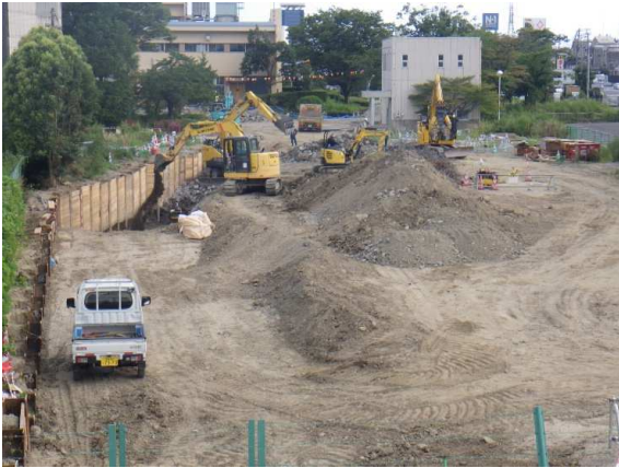
既設放流渠撤去部埋戻し状況
