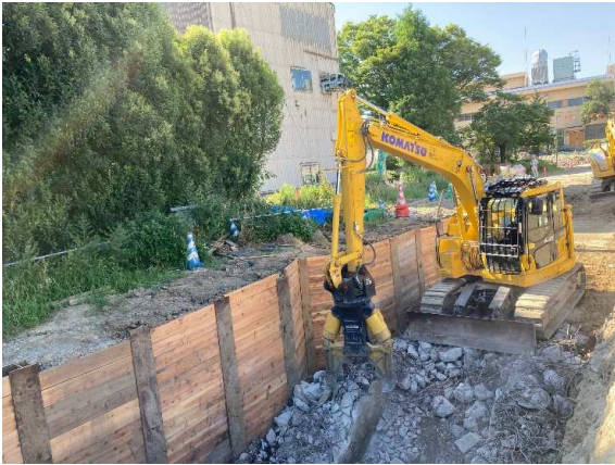
既設放流渠撤去状況
