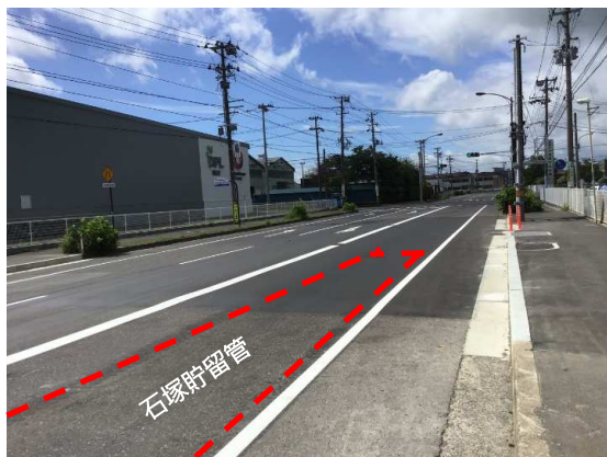
到達立坑部舗装本復旧完了
