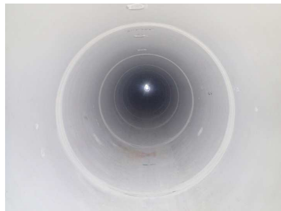
貯留管内部状況
