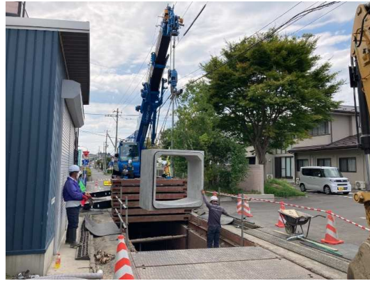
ボックスカルバート布設状況
