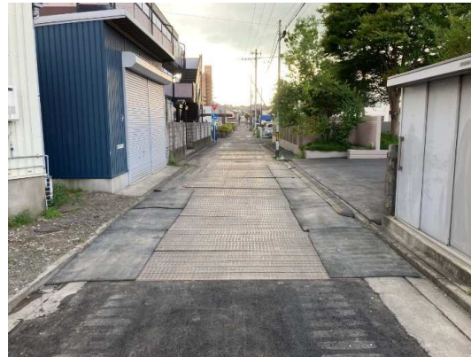
覆工板設置状況
