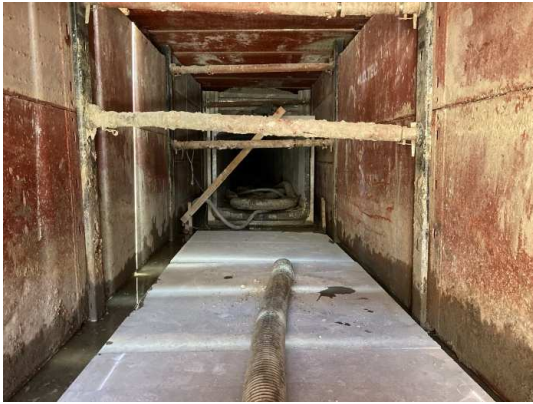
土留め・基礎版設置完了
