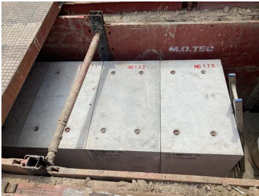
ボックスカルバート布設完了
