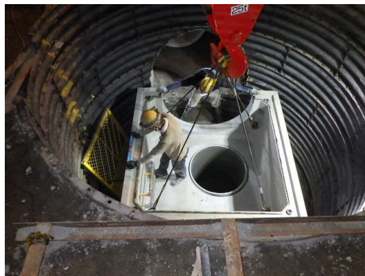
分水人孔③流入管取込人孔設置状況
