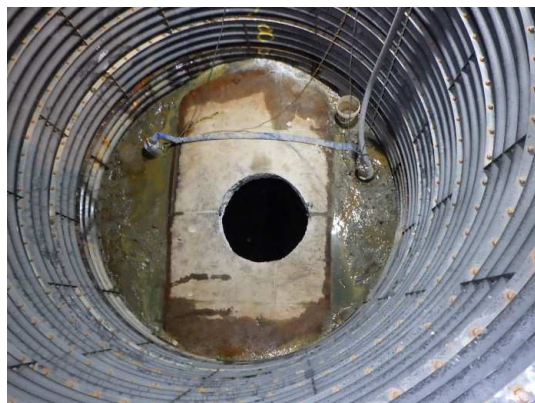
分水人孔③貯留管削孔完了
