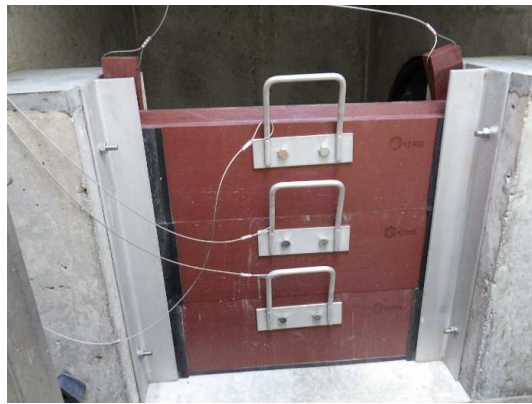
分水人孔②内部角落し設置完了
