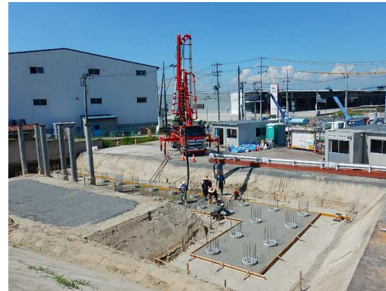
L型擁壁均しコンクリート施工状況
