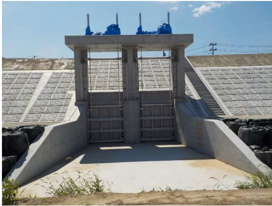
取付護岸完了
