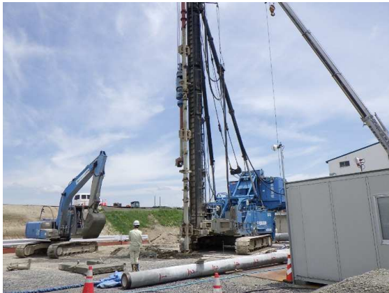
コンクリート杭施工状況
