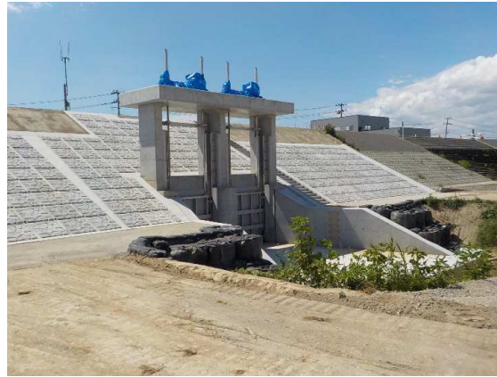
取付護岸完了
