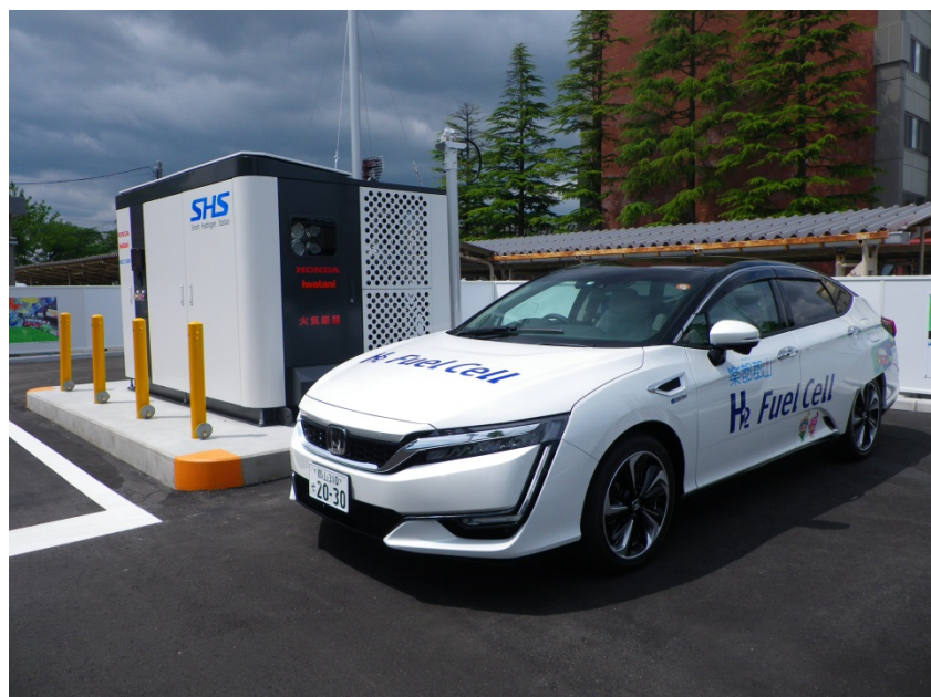
郡山市役所に設置した水素ステーションと燃料電池自動車（FCV）
