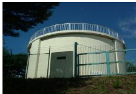
②配水施設(配水池)
