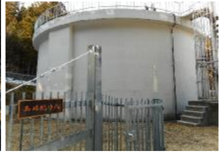
②配水施設(配水池)
