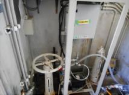
③配水池(建屋内部)
