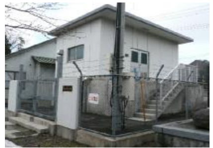
②配水施設(配水池)
