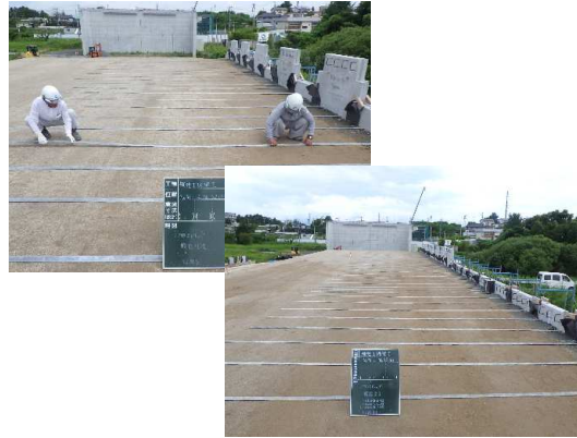
ストリップ設置状況
