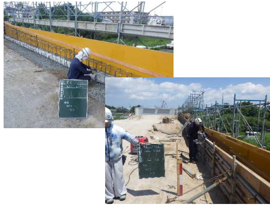
笠石コンクリート工(配筋～型枠組立)状況
