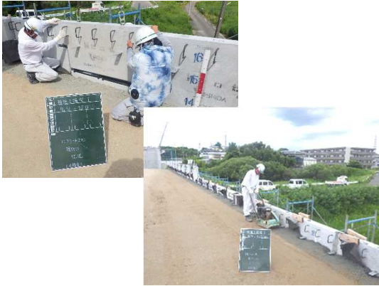
コンクリート壁面材(4段目)設置状況
