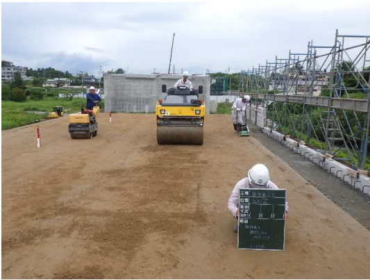
路体盛土(敷き均し～転圧)状況
